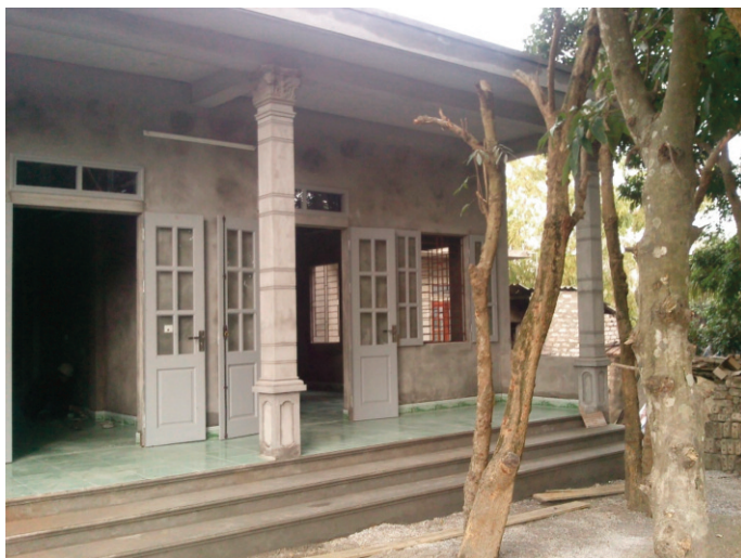
Un rez de chaussée terminé
